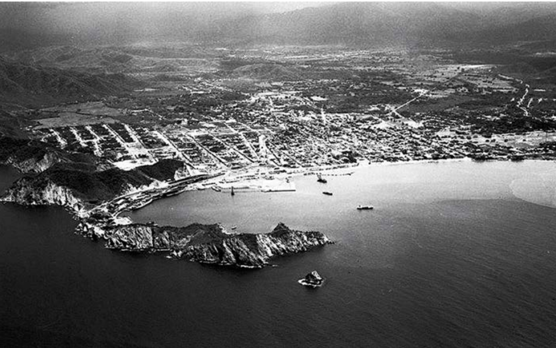
Proceso de construcción de la primera etapa de expansión portuaria, 1954 Archivo: Omar Arciniegas.
