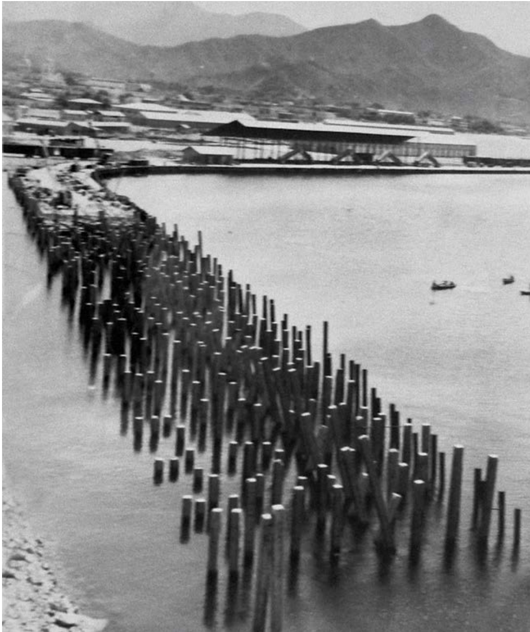
Pilotaje durante la segunda etapa de ampliación portuaria, 1958 Archivo: Alberto Simancas.
