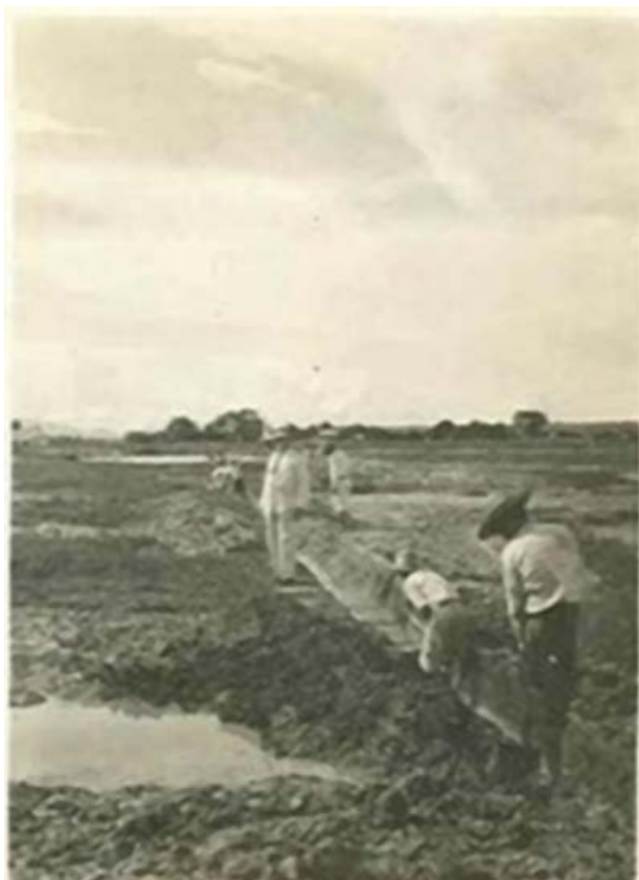
Labores de drenaje para el control del paludismo en Neiva
